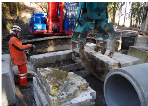
Bauarbeiten im neuen REDOG-Trainingsgelände in Ostermundigen
