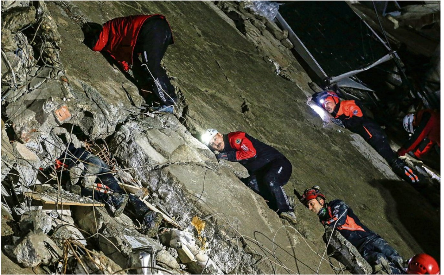
Des secouristes recherchent le moindre signe de vie, l'oreille collée contre les blocs de béton d'un immeuble effondré à Iskenderun. EPA/ERDEM SAHIN
