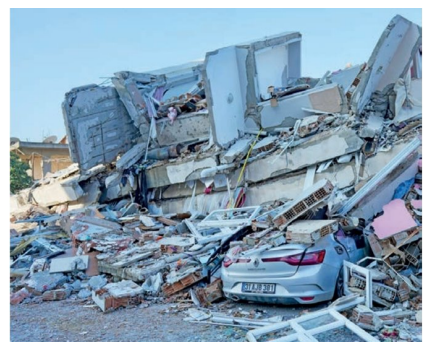
Eine Stadt in Trümmern. Statiker und Ingenieure beurteilten, welche der eingestürzten Gebäude betreten werden durften. Bild: EDA
